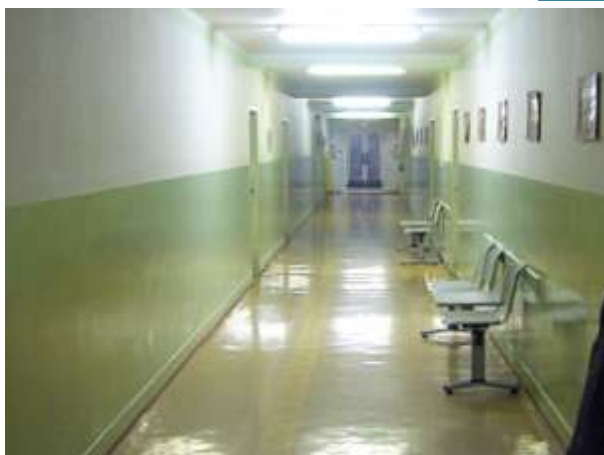
Stav pred rekonštrukciou
