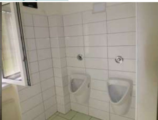
Stav po rekonštrukcii
