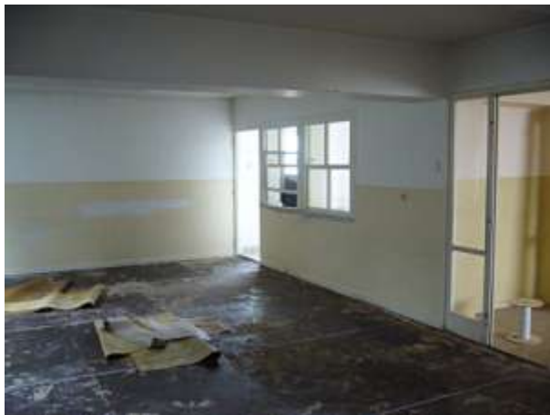
Stav pred rekonštrukciou
