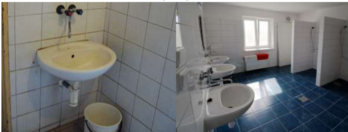
Stav pred rekonštrukciou
