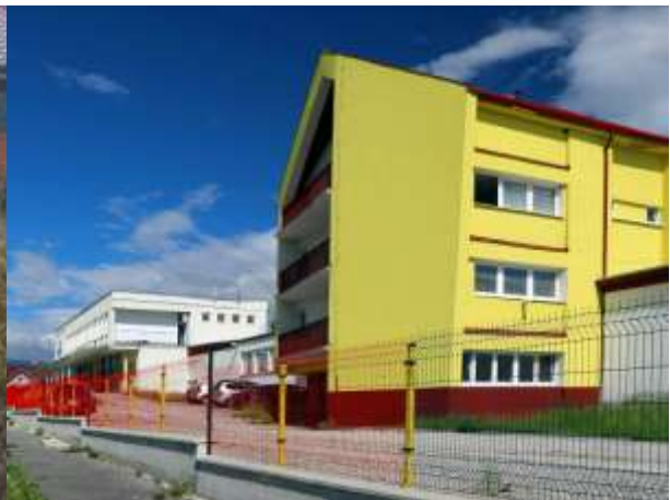
Stav po rekonštrukcii
