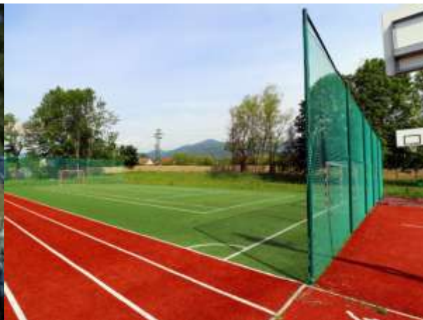
Stav po rekonštrukcii
