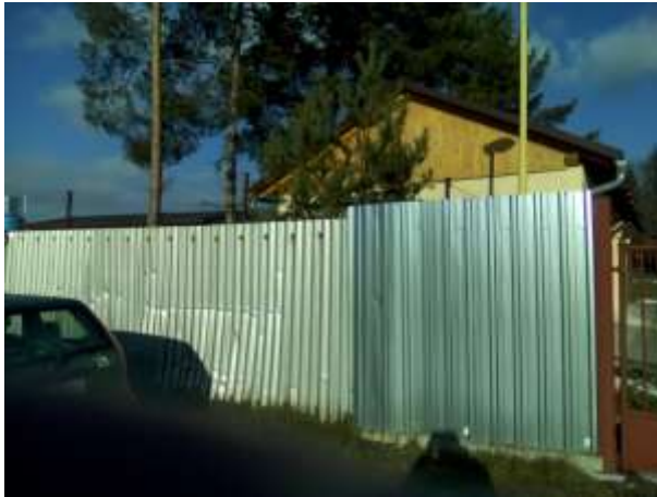
Stav pred rekonštrukciou
