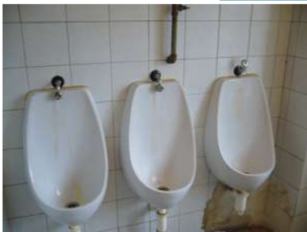
Stav pred rekonštrukciou
