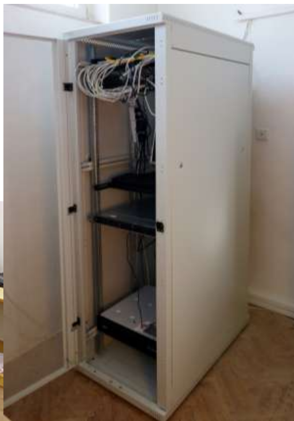
Stav po rekonštrukcii
