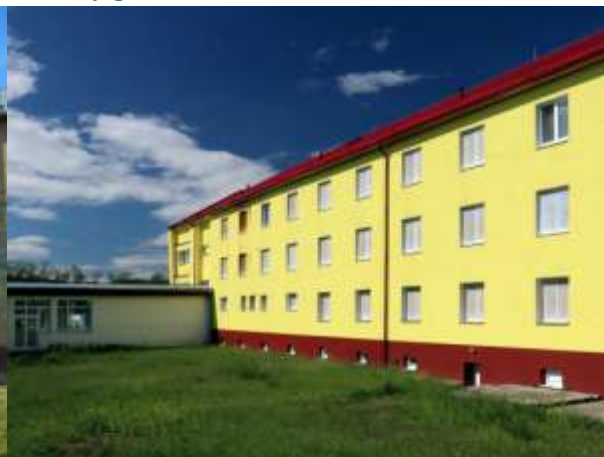
Stav po rekonštrukcii
