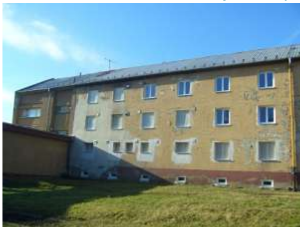
Stav pred rekonštrukciou
