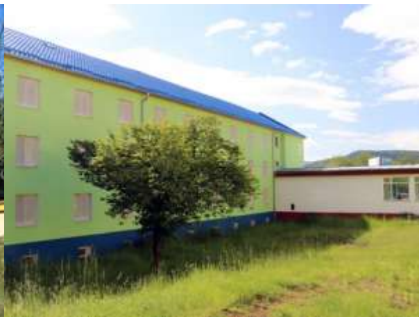
Stav po rekonštrukcii
