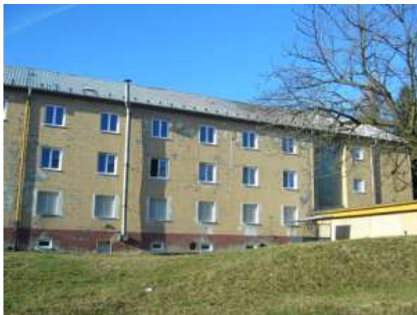
Stav pred rekonštrukciou
