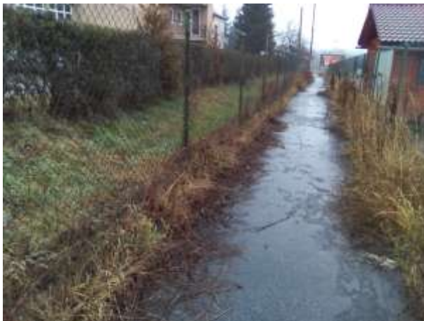
Stav pred rekonštrukciou
